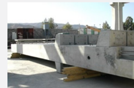
Poteaux avec corbeau d'appui de plancher intermédiaire
