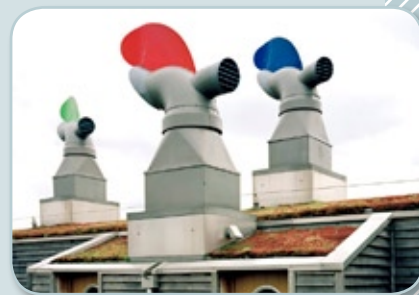
BEDZED 3 : Les trompettes à double flux fonctionnent avec la seule énergie du vent, elles utilisent la chaleur de l'air vicié pour chauffer l'air neuf, 50 à 60 % de calories récupérées.
