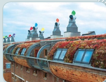
BEDZED 4 : La végétalisation des toitures permet de mieux isoler et de récupérer les EP par un drainage approprié.
