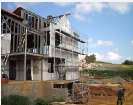
Premier chantier de maison individuelle en plaque ciment KNAUF AQUAPANEL en Algérie
