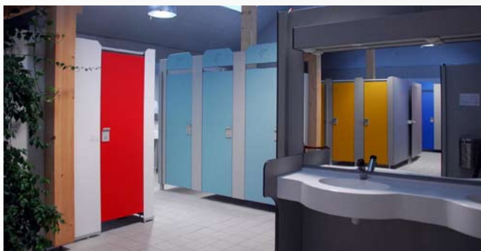
Clipsoplaque sur placard séparatif, vitrage bord à bord collé
