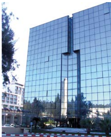
Figure 1 : Vues extérieures de l'édifice
