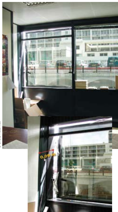
Figure 4 : Baie de l'intérieur des bureaux et fenêtre de désenfumage
