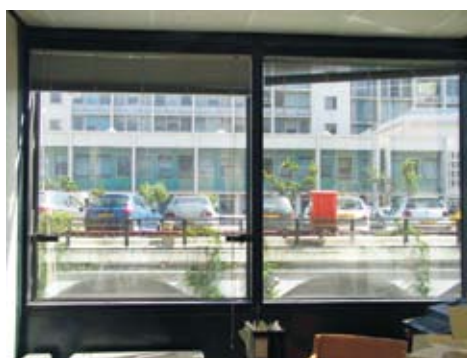
Figure 4 : Baie de l'intérieur des bureaux et fenêtre de désenfumage
