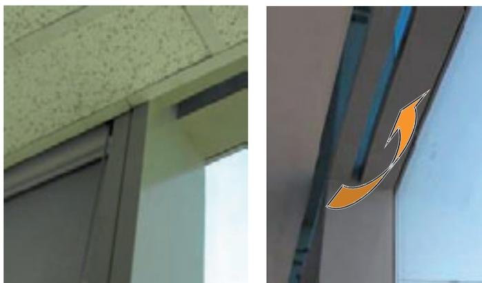
Le système d'isolation par le vitrage est complété par un dispositif de ventilation naturelle permise par les profilés aluminium utilisés avec l'aide des stores déroulants intégrés.
